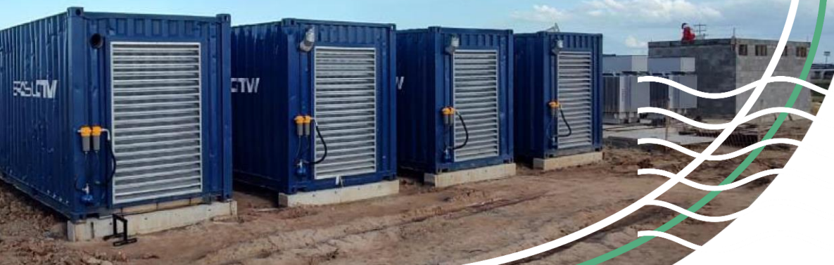
Sistema de geração de energia a gás em fase final de comissionamento | Polo Macau
