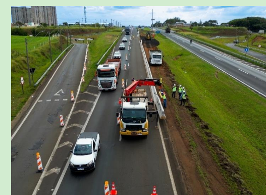
Ecovias Noroeste Paulista: obras de terceiras faixas em São Carlos – SP
