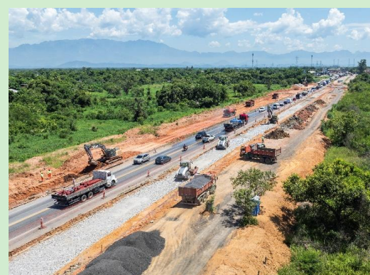
Ecovias Rio Minas: obras de ampliação da BR-483/RJ - trecho Magé-Manilha
