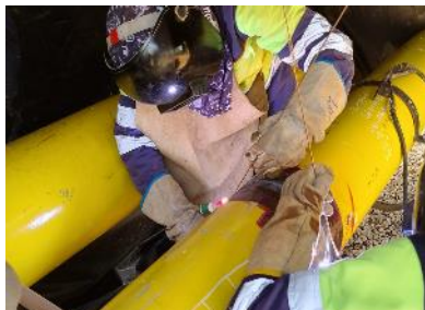
Soldagem da tubulação de gás
