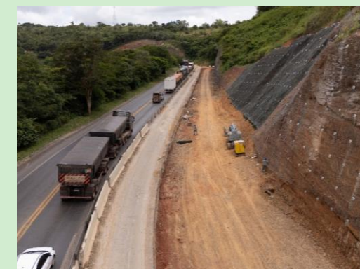
Eco135: Obras de duplicação entre Montes Claros/MG e Bocaiúva/MG
