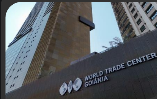
Edifício Comercial WTC Goiânia – GO
