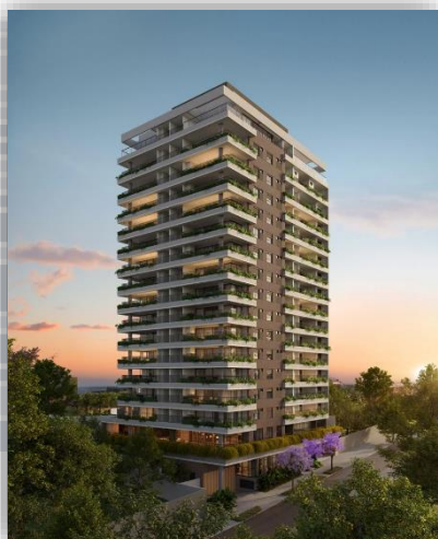
* Fachada em 3D do Aire Alto de Pinheiros.
