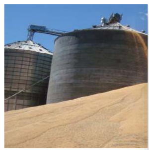
COLAPSO DA INFRAESTRUTURA
