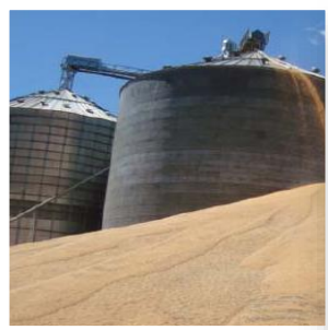
COLAPSO DA INFRAESTRUTURA
