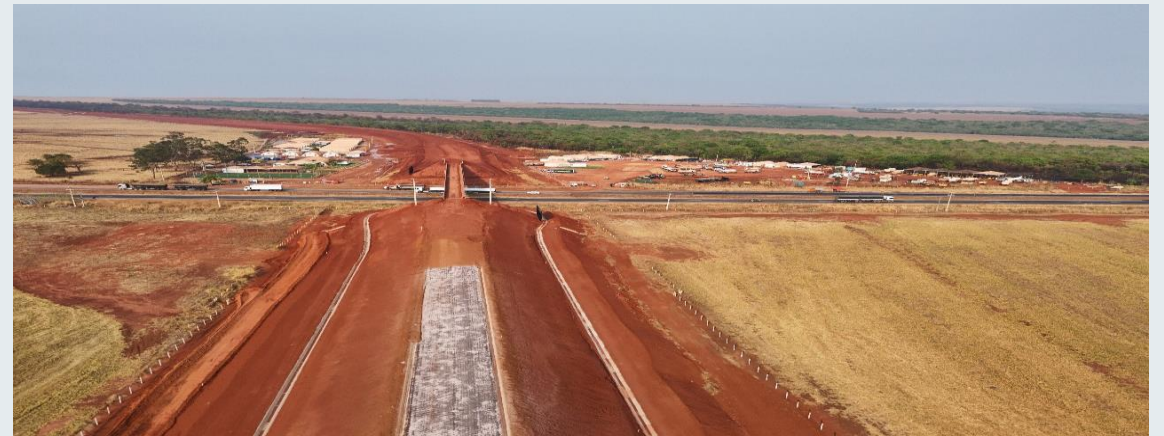
Canteiro de obras dos primeiros 35 km da extensão
