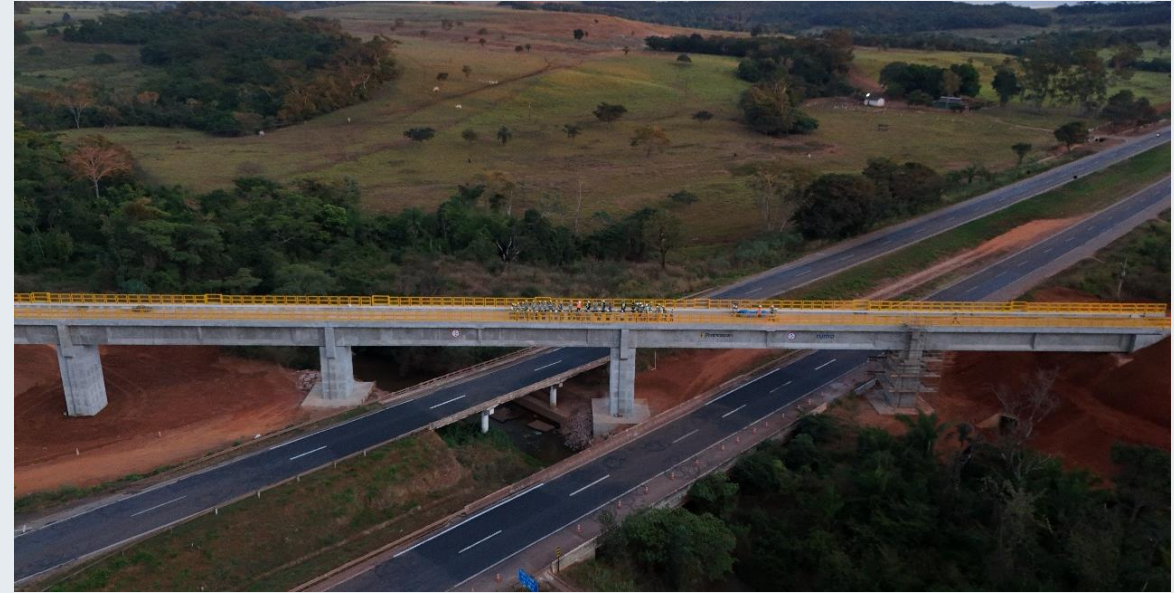
Viaduto sobre a BR163, saída de Rondonópolis, OAE concluída
