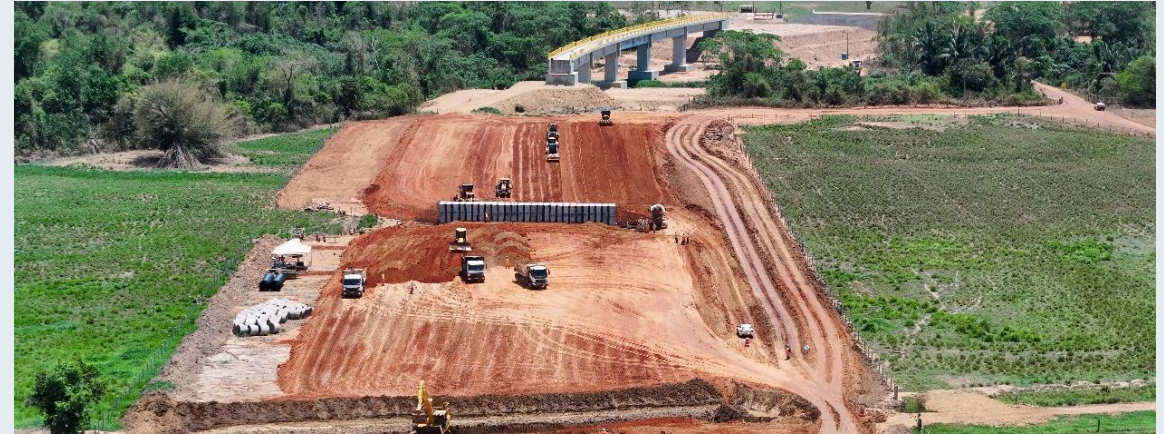
Trabalho de terraplenagem e viaduto sobre o Rio Areal.
