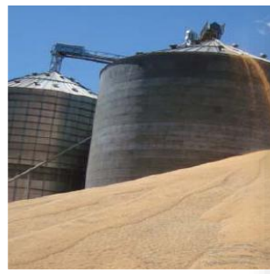
COLAPSO DA INFRAESTRUTURA
