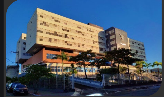
Vila Velha Hospital – ES
