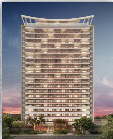
*Fachada em 3D do The Collection Moema.
