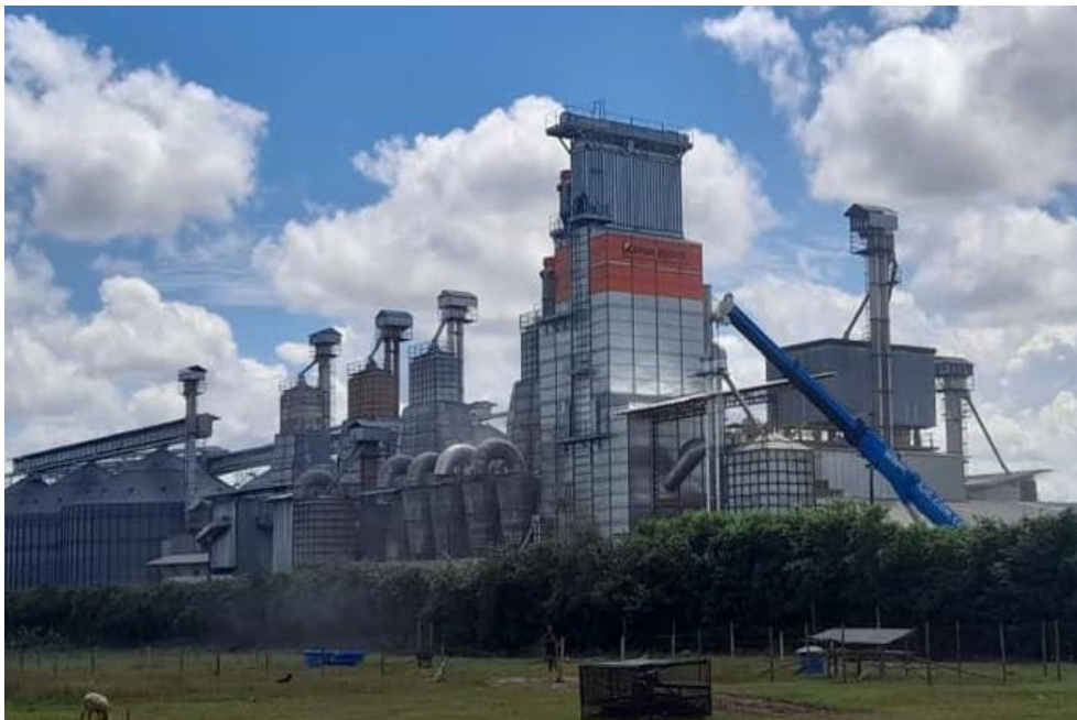
Secador Dryer | Capac. de 3,8 mil sacas de arroz
